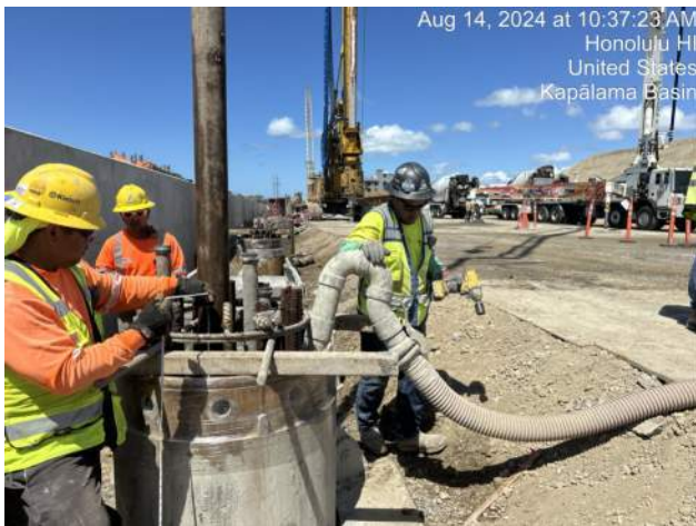
KIWC pouring shaft 11-A3S-36
