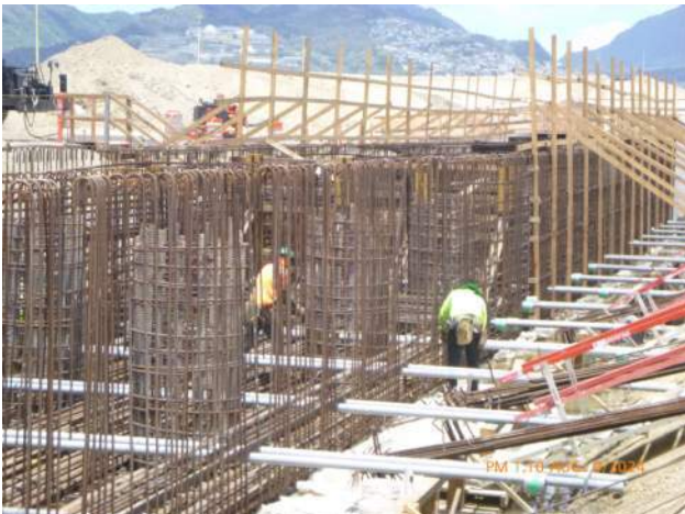
HRSPI installing rebar for LSCRB pour #8.
