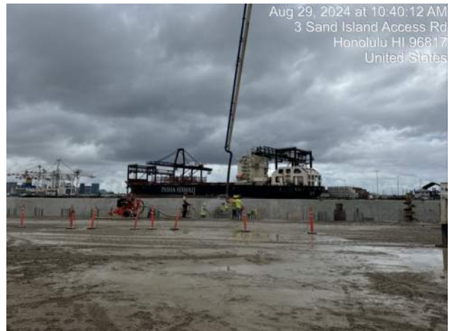
KIWC starting to pour CIDH shaft 15-A2s-36
