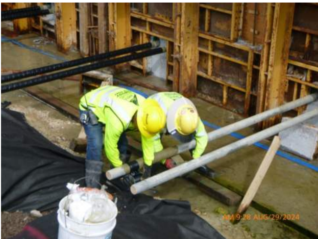
KIWC wrapping tie rods embedded in LSCR pour #7 with tape.
