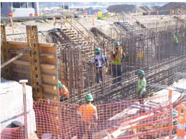
HRSPI installing rebar for LSCRB pour #8.
