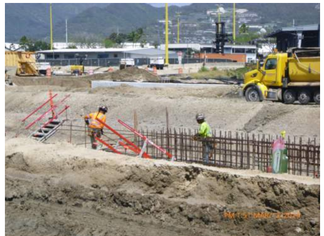
HRSPI installing rebar for TD-3 pour #6.
