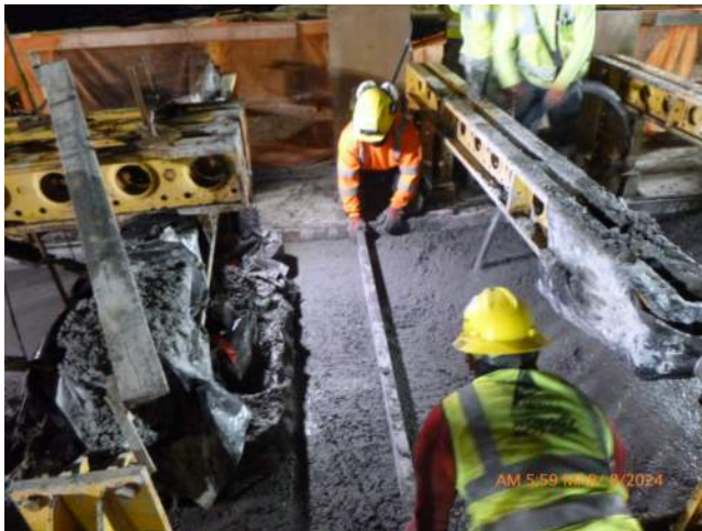
KIWC finishing the surface of capping beam pour #14.
