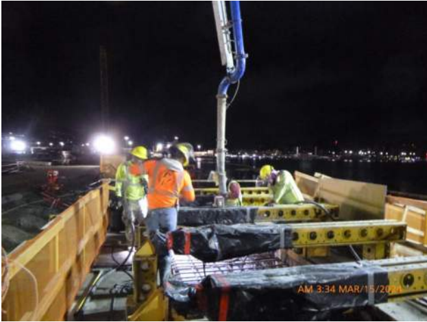
KIWC pouring concrete into capping beam pour #14 on pier 42.
