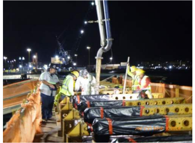
KIWC pouring concrete for capping beam pour #14.
