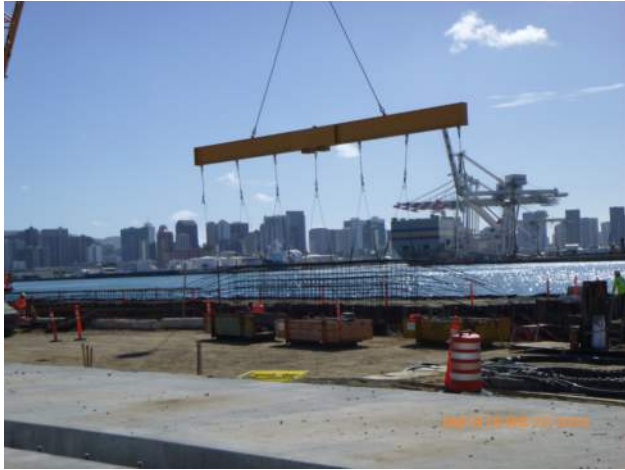
KIWC setting rebar cage over capping beam pour #15.
