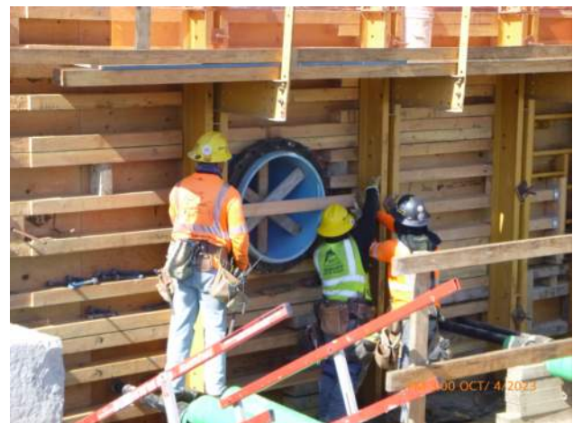
KIWC setting formwork for Pier 42 LSCRB pour #1.
