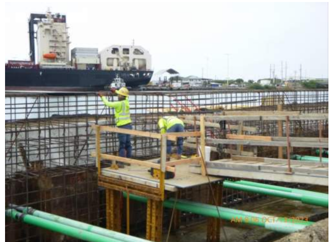
KIWC installing formwork for capping beam pour #7.
