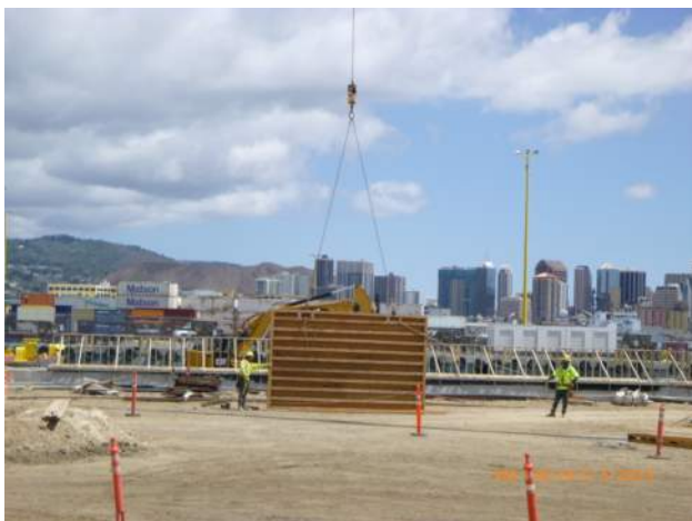
KIWC setting formwork for LSCRB pour #1 on pier 42.
