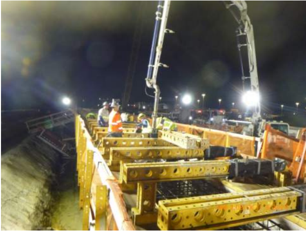
KIWC pouring capping beam pour #3 on pier 42.
