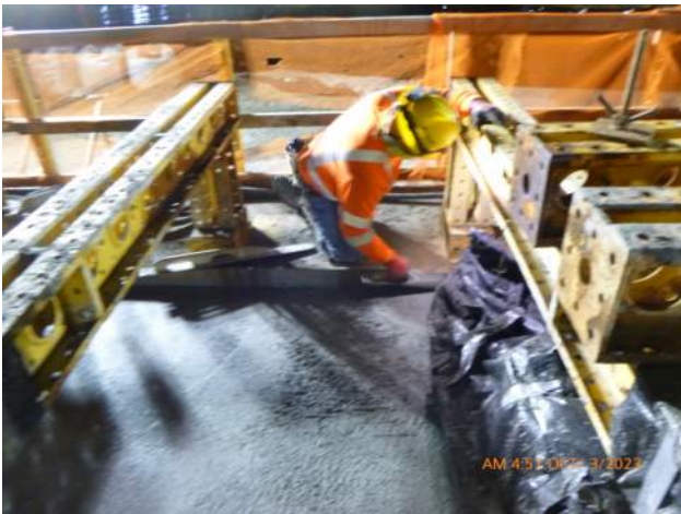
KIWC finishing the surface of capping beam pour #3.
