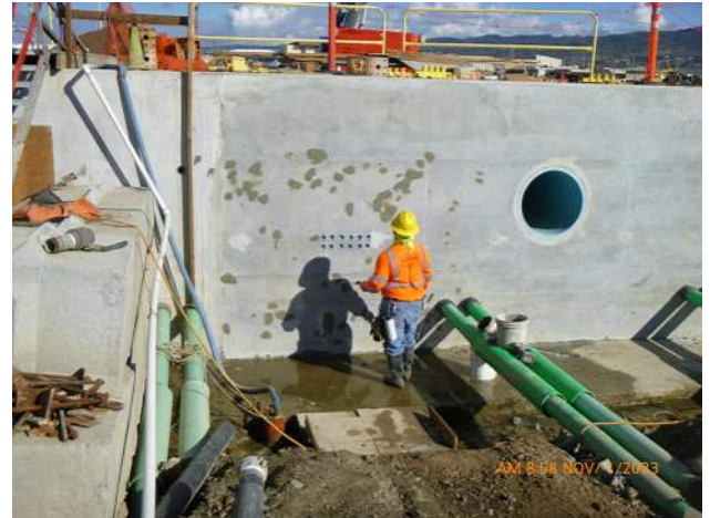
KIWC finishing the surface of LSCRB pour #1.
