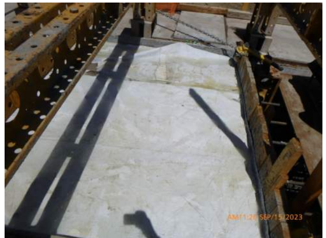
KIWC setting up a wet cure for Pier 42 capping beam pour #4.
