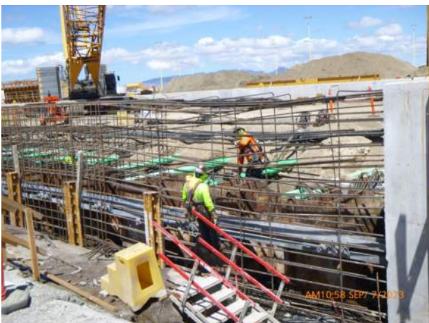
HRSPI installing rebar cage for P42 capping beam pour #3.
