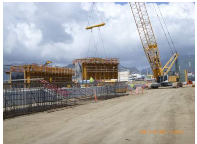
KIWC installing formwork for P42 capping beam pour #4.
