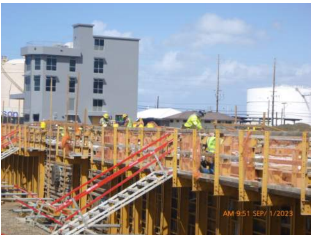
KIWC installing formwork for P43 LSCRB pour #6.
