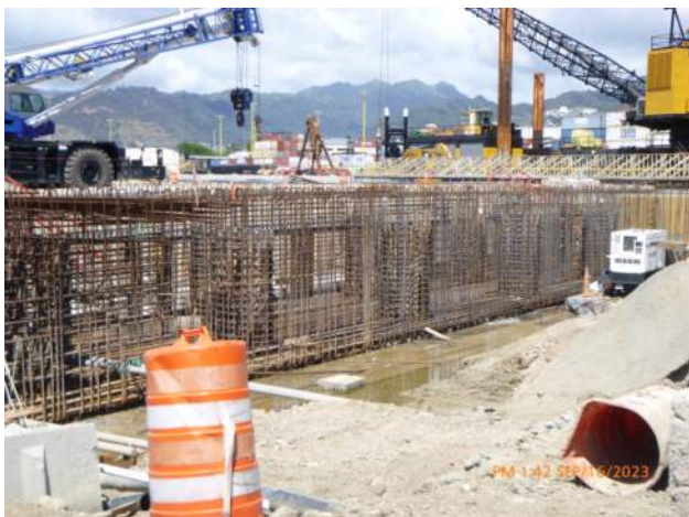
HRSPI installing rebar cage for Pier 42 LSCRB pour #1.
