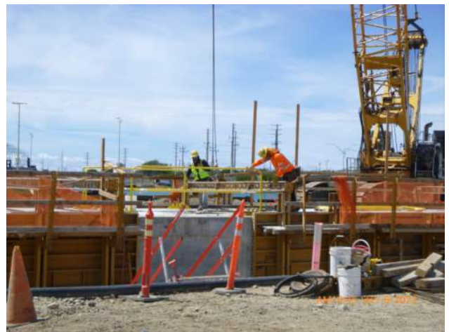
KIWC installing formwork around P43 LSCRB pour #5.
