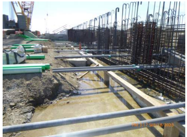
KIWC installing tie rods in LSCRB pour #1 on pier 42.
