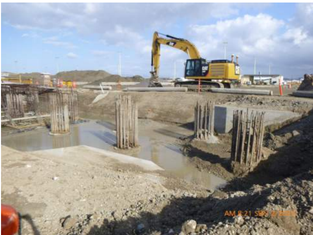
View of the P42 LSCRB pour #1 excavation.
